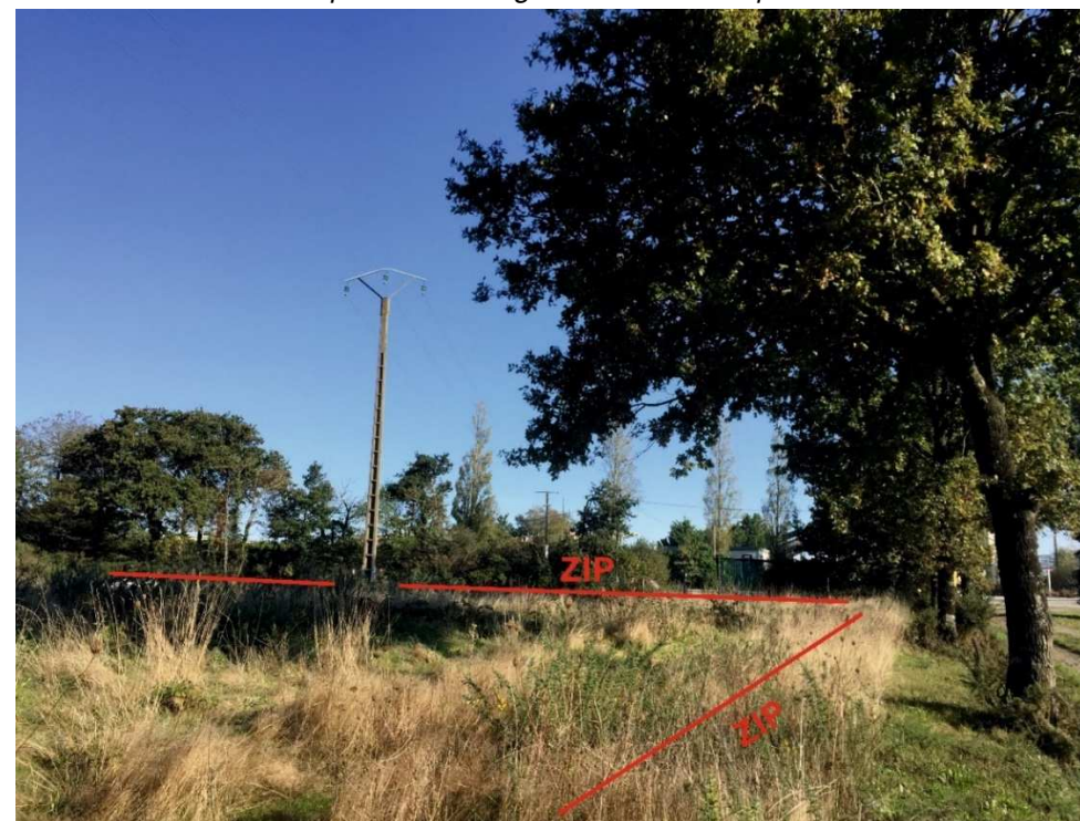
Illustration 92 : Vue du poteau de la ligne haute tension présent sur le site d'étude
